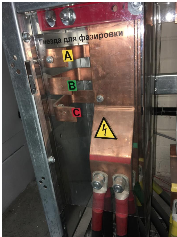
Рис.7 – Защита узла проверки совпадения фаз прозрачным диэлектриком (по аналогии)
