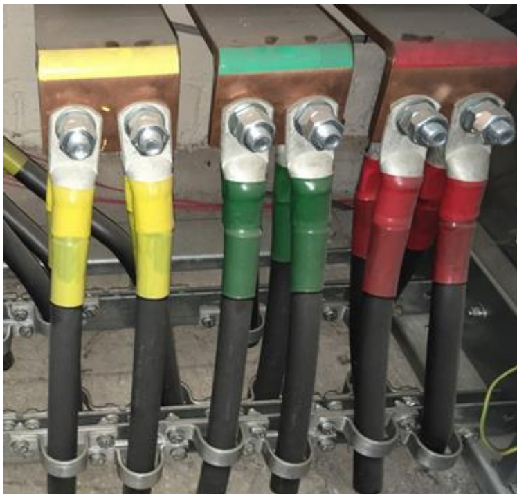
Рис. 8 - Хомуты из немагнитного материала (алюминий или аналогичные немагнитные металлические сплавы) для крепления секционных перемычек.
